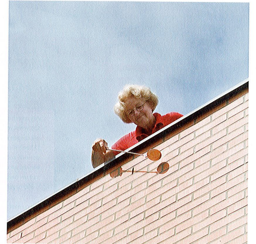
Met behulp van een spiegeltje bekijkt Hanneke de staat van de dakrand.
